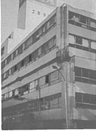
شكل (٣) انهيار أحد الطوابق المتكررة تشكيل طابق رخو،
