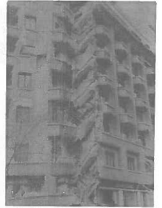
شكل (٥) انهيارات في البلكنات أو الطيران، لتجنب الإنهيار هناك حاجة لتصميم خاص
