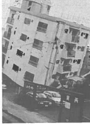
شكل (٢) انهيار الطابق الأرضي، طابق رخو،
